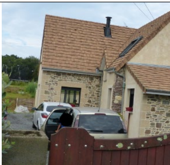
Maison d'habitation en pierre et terre – le Boscq
