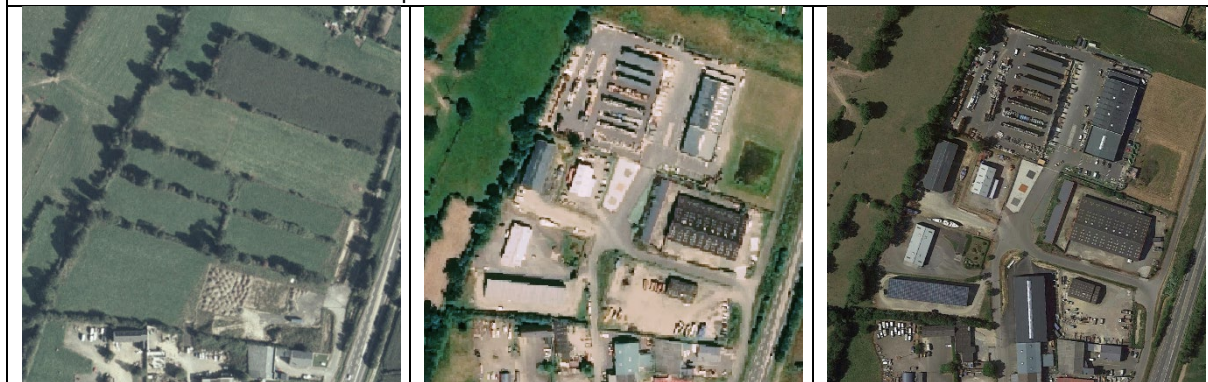
ZA des Delles – haies détruites par l'extension de l'urbanisation
