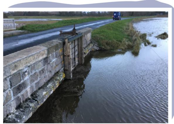
Force est de constater qu'elle ne remplissait plus correctement sa fonction, La commission syndicale des Landes et Marais décide en 2016, de remplacer cette porte à flots, gérée manuellement, par une version automatisée.
